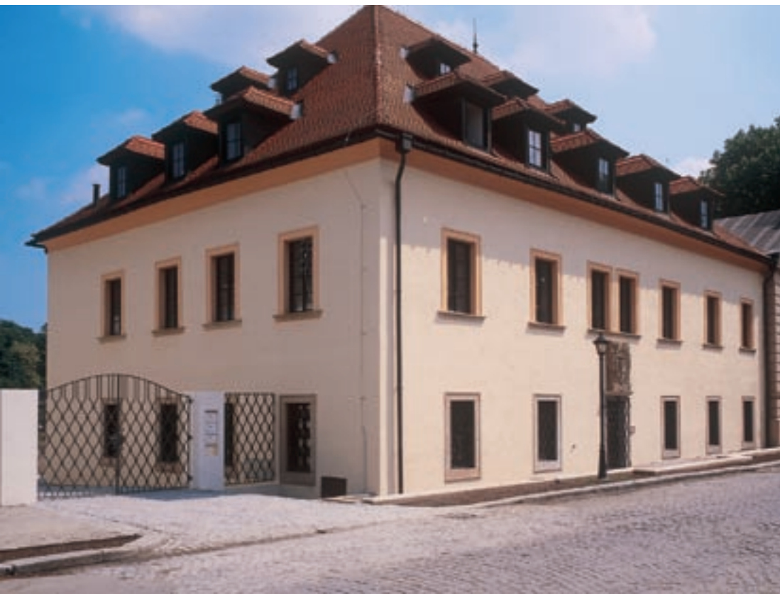
Současný stav mincovny po provedení regenerace objektu
